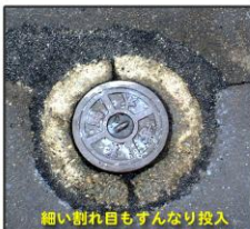
細い割れ目もすんなり投入
