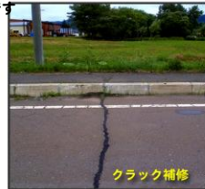
クラック補修
